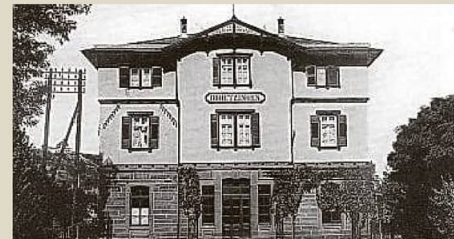
Die Anfänge im Alten Bahnhof Brötzingen am 22.10.1899
